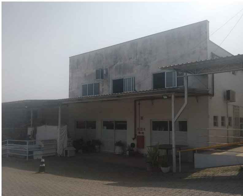
Figura 26 - Prédio Brechó, Bazar e PEP.
