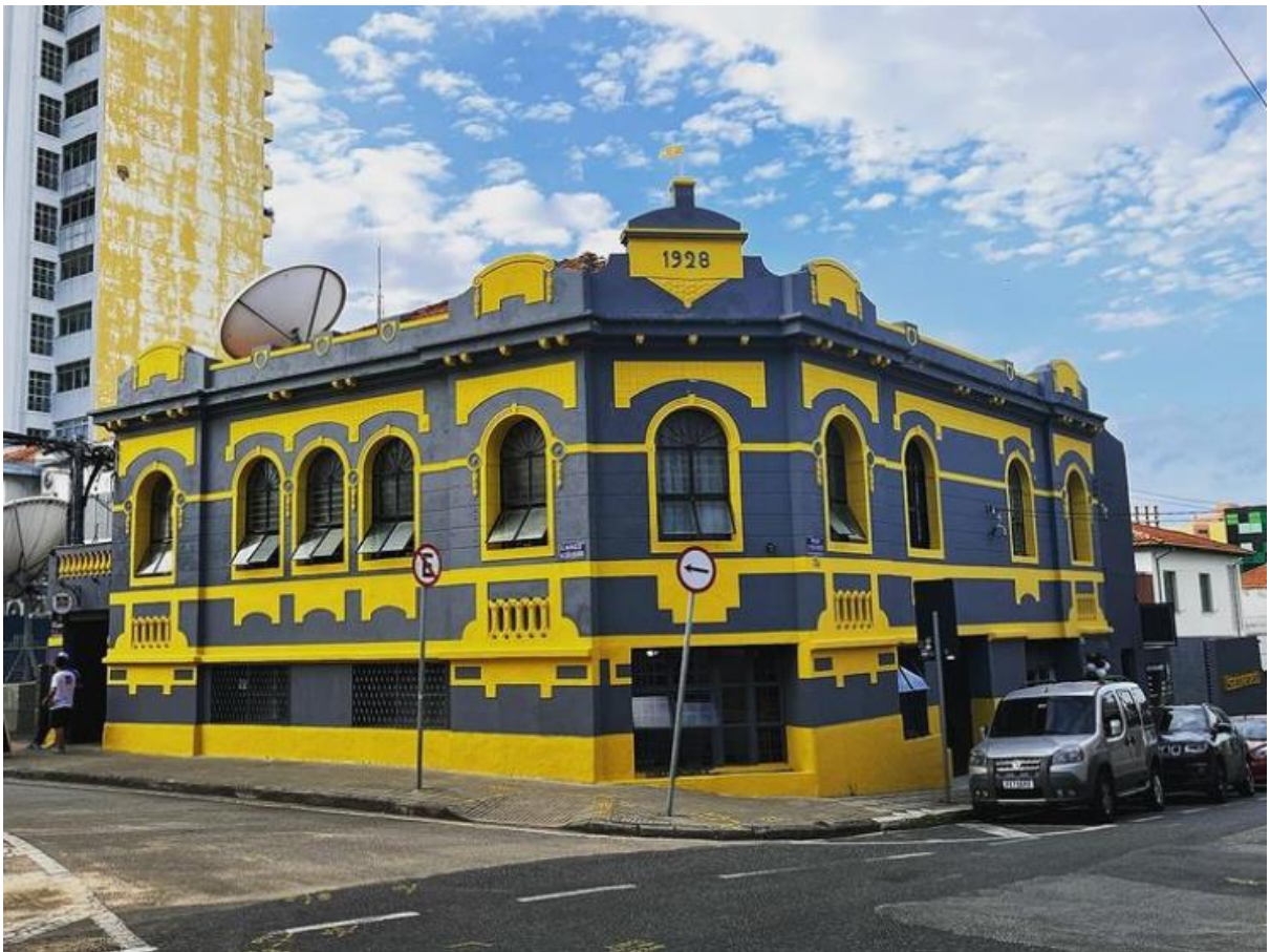
Imagem 13 - Fachada Centro Cultural JF
